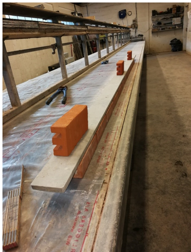
Figur 1. Billedet viser retholt på en overligger
