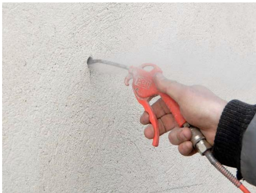
Fig. 5. Hullet blæses rent for støv.
