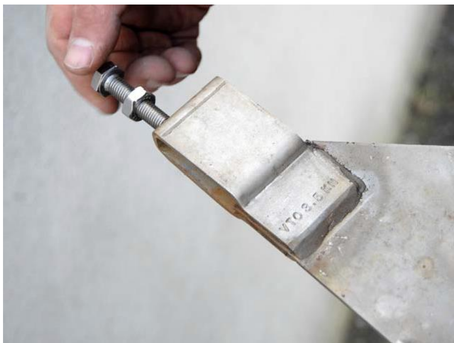
Fig. 8. Der monteres topbolt for finjustering af højde.
