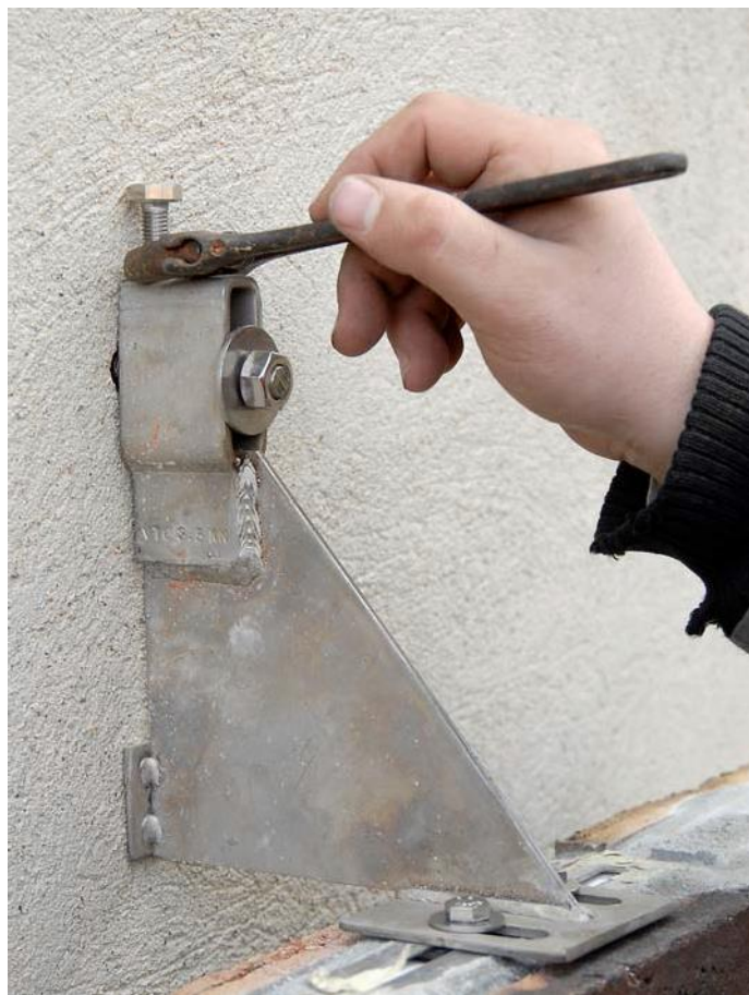
Fig. 18. Topbolten justeres, så tegloverliggeren flugter med skiftegangen.
