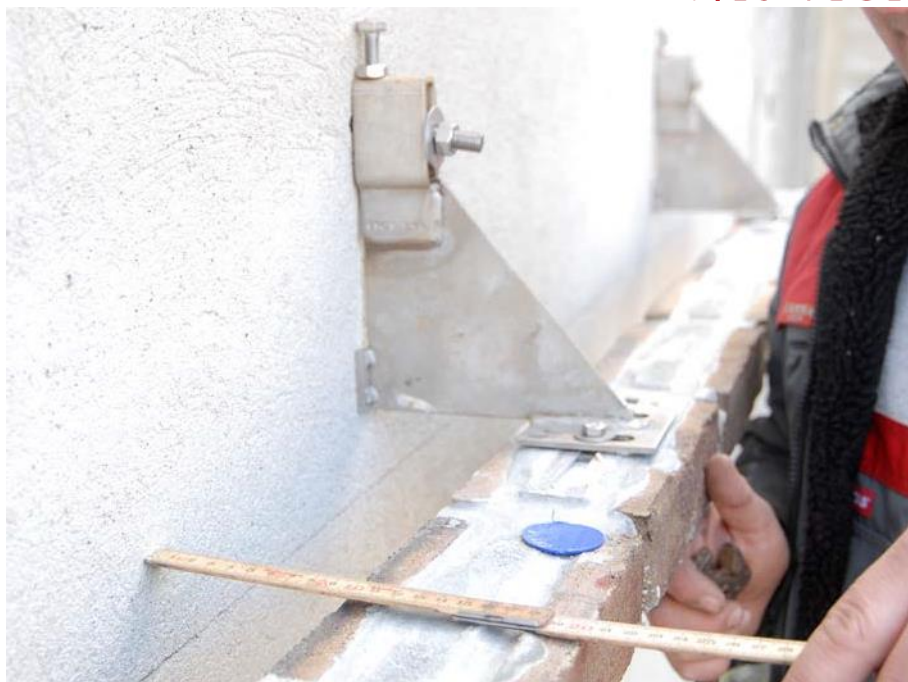
Fig. 16. Justering af dybde til bagmur.
