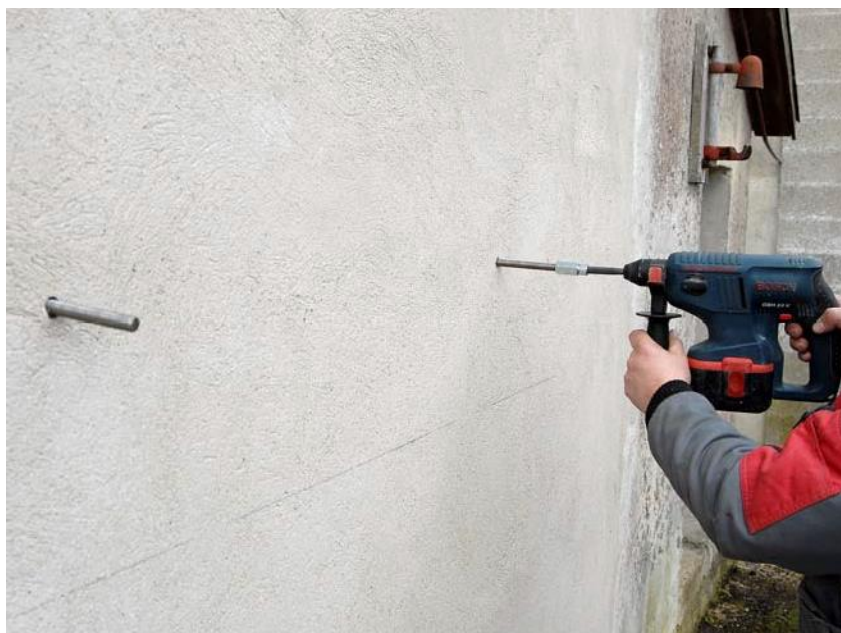
Fig. 7. Genvindstangens skråleble spids stikkes ind i limampulen og der bores med slagboremaskinen ind i limampulen. Hærdetiden på limampulen vil variere afhængig af temperatur og kan aflæses på medsendte æske.
