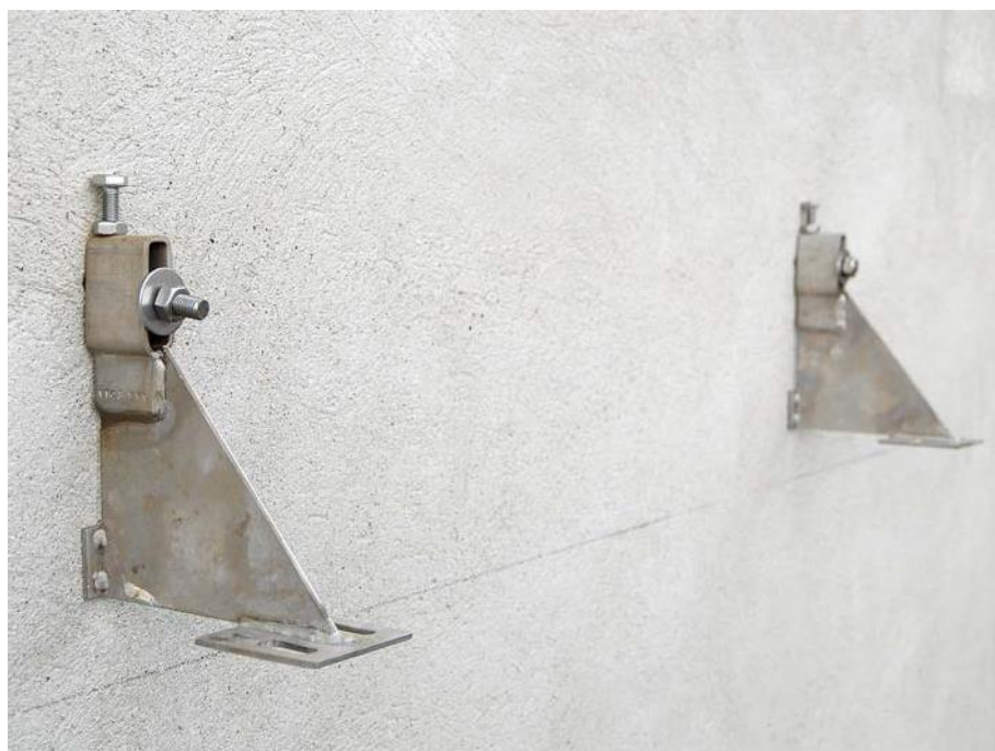
Fig. 11. Afstanden mellem konsollerne vil variere. Fra Vils Tegloverliggerne vil der medsendes tegningsmateriale for afstanden mellem konsollerne.
