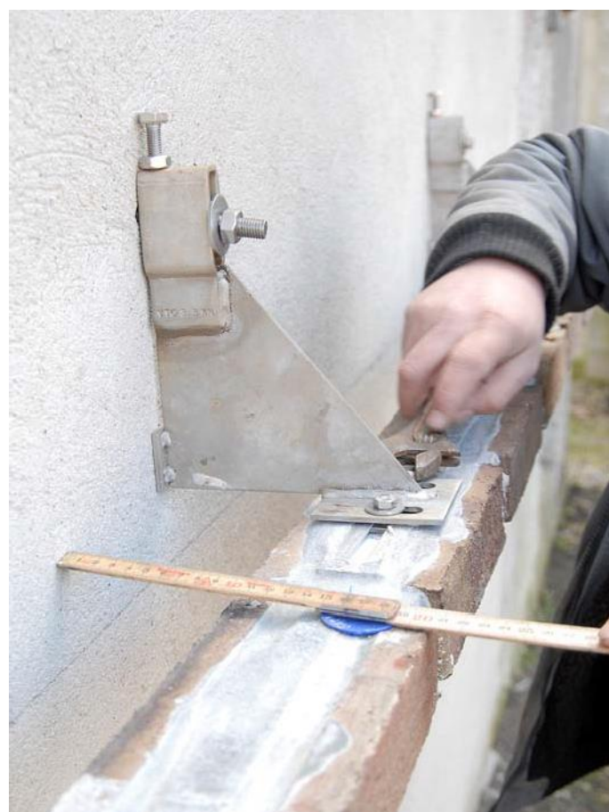
Fig. 17. Efterspænding af bolte i glideskinne for dybdejustering til elementet. (Bolten må ikke spændes hårdt og man skal sikre sig, at konsolfoden støtter jævnt på glideskinnen).
