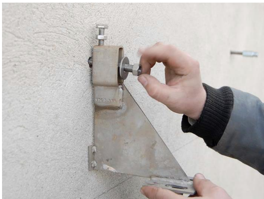
Fig. 9. Konsol monteres på indlimmet gevindstykke.
