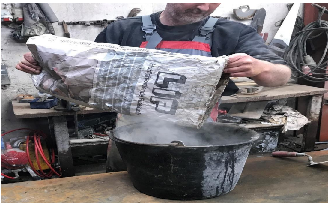
Billede nr. 11. Der skal anvendes frostfast fliseklæb .
