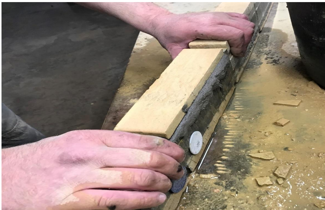
Billede nr. 15. Påfør stenen så fliseklæb klemmes ud.
