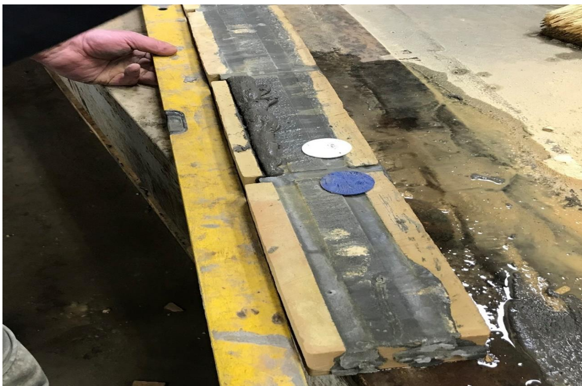
Billede nr. 17. Påfør et retholt for at sikre sig at stenen er i flugt.
