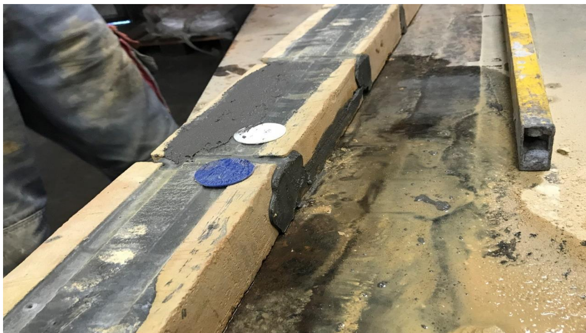
Billede nr. 18. Fjernelse af overflødigt fliseklæb.
